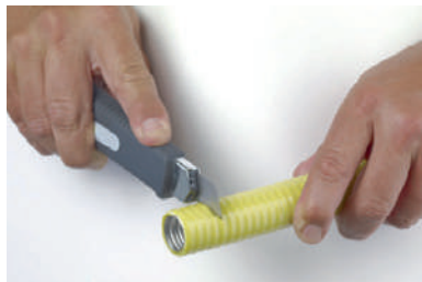
Dénuder le tuyau FLEXIPIPE à l'aide d'un cutter.
