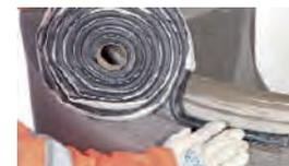
Mettre en place le joint dans la rainure et ôter la protection
