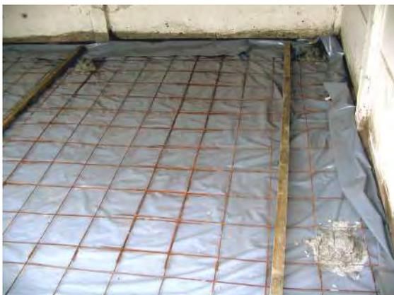
Le BATIDALL est un film tri-couches de 150μ réels d'épaisseur, fabriqué par coextrusion. Grâce à ce procédé, il est doté d'une excellente résistance mécanique, ce qui en fait la membrane appropriée pour assurer l'étanchéité de vos ouvrages. Ce film sous-dalle est la solution idéale pour la réalisation de vos dalles et chapes béton en les protégeant de façon pérenne des remontées capillaires.
