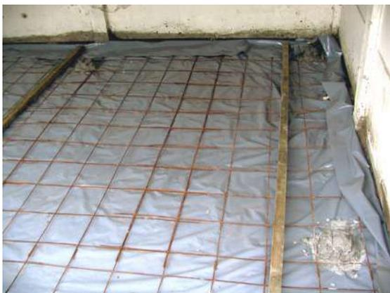
Le BATIDALL est un film tri-couche de 150μ réels d'épaisseur, fabriqué par coextrusion. Grâce à ce procédé, il est doté d'une excellente résistance mécanique, ce qui en fait la membrane appropriée pour assurer l'étanchéité de vos ouvrages. Ce film sous-dalle est la solution idéale pour la réalisation de vos dalles et chapes béton en les protégeant de façon pérenne des remontées capillaires.
